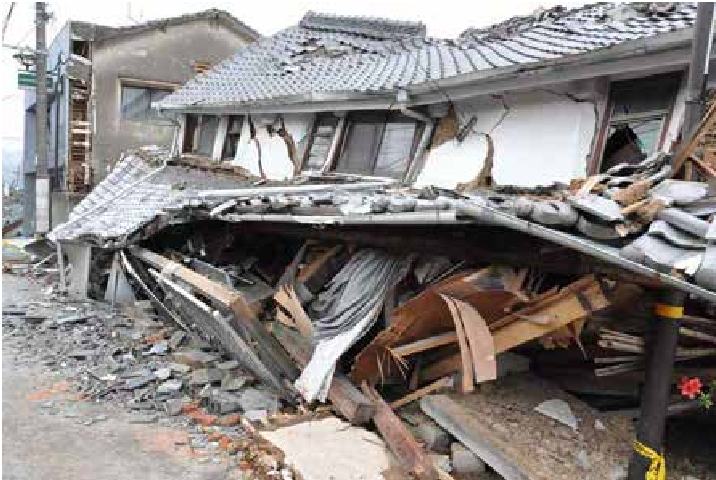
重い瓦屋根、通りに面した開口部の広い古い木造住宅(益城町木山)
