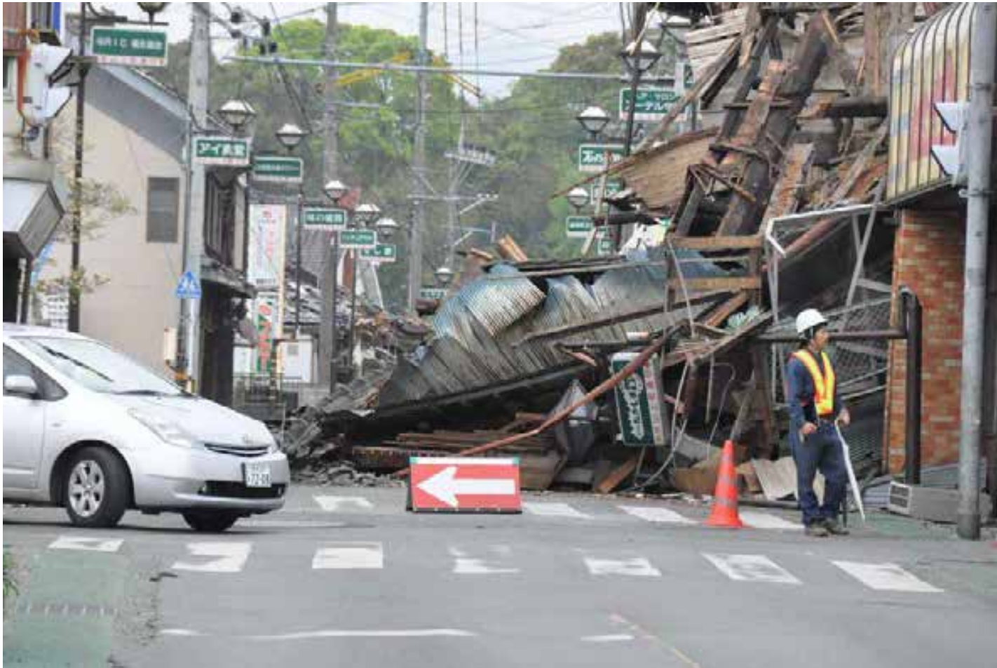
倒壊した家屋が倒れ込み主要な道路が通行止めに(益城町木山)
